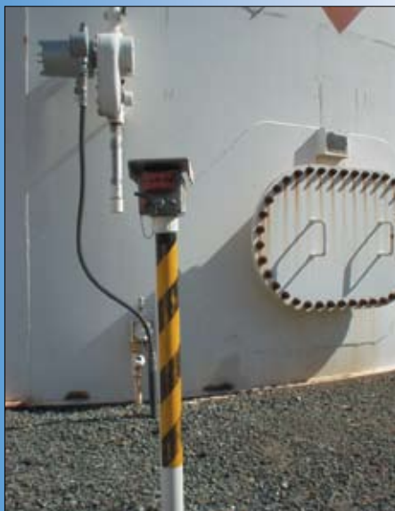
PVC导管中的TT5000传感电缆可放置于埋地阀门下方或地面储罐底部之下。
