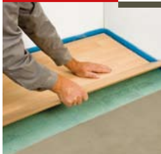
Pose du parquet flottant
