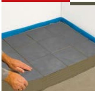
Pose du carrelage
